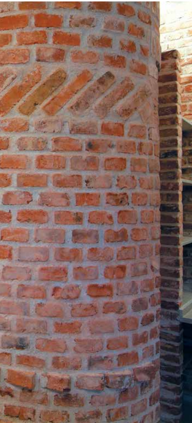
Hotelværelse i den tidligere avlsgård på Hindsgavl Slot. Her har genbrugstegl gjort gavn både æstetisk og CO 2 -mæssigt.
