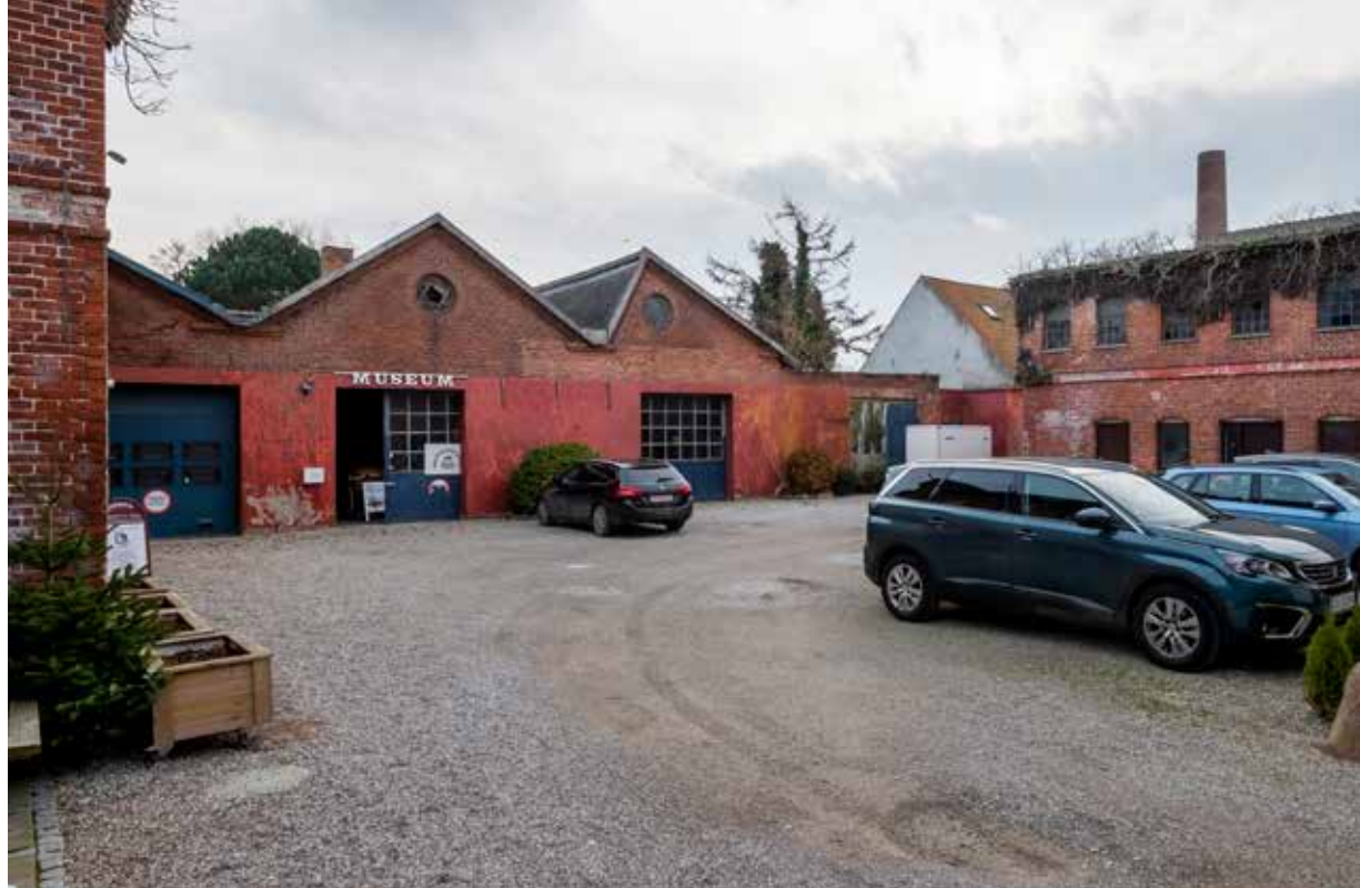
Støberihallerne i Præstø. Shedtaget giver mest muligt lys ned i de lange haller, og zigzag-formen er typisk for tidens industribygninger.
