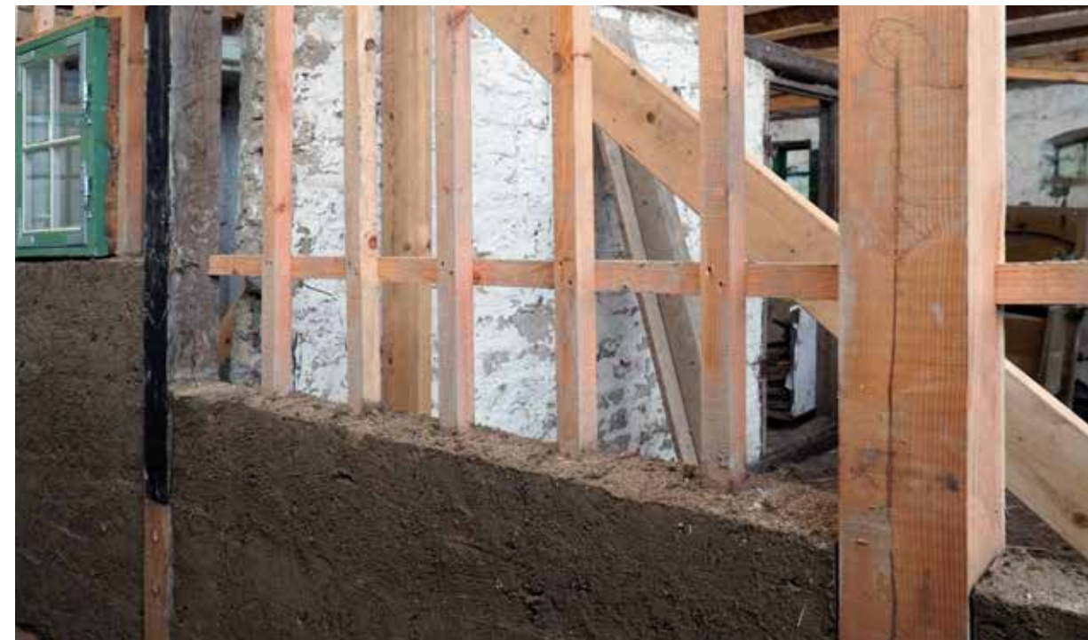
Mellem stolperne er fagene lukket med en blanding af ler, hestepærer, kærnemælk og halmsnitte.
