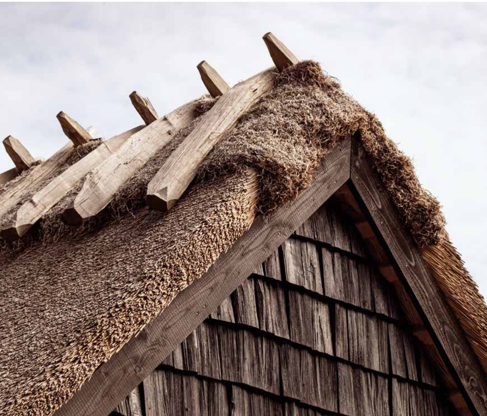
Kragetræerne på toppen af mønningen er af egetræ, mens gavlen er beklædt med spån af fyrretræ, der er behandlet med træbjærev.
