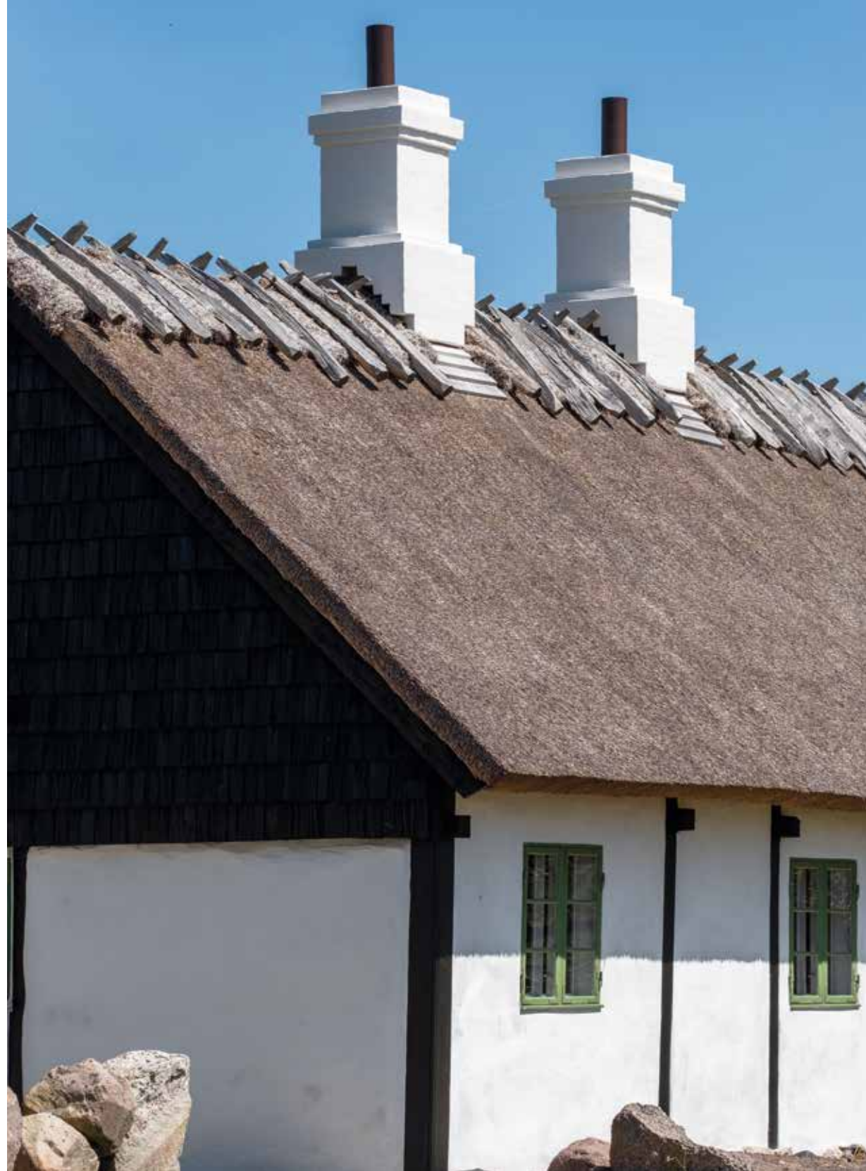
Alle længer er igen tækket med strå og med mønning af ålegræs og kragetræer. Også de to skorstene er genskabt, som de oprindeligt så ud.
