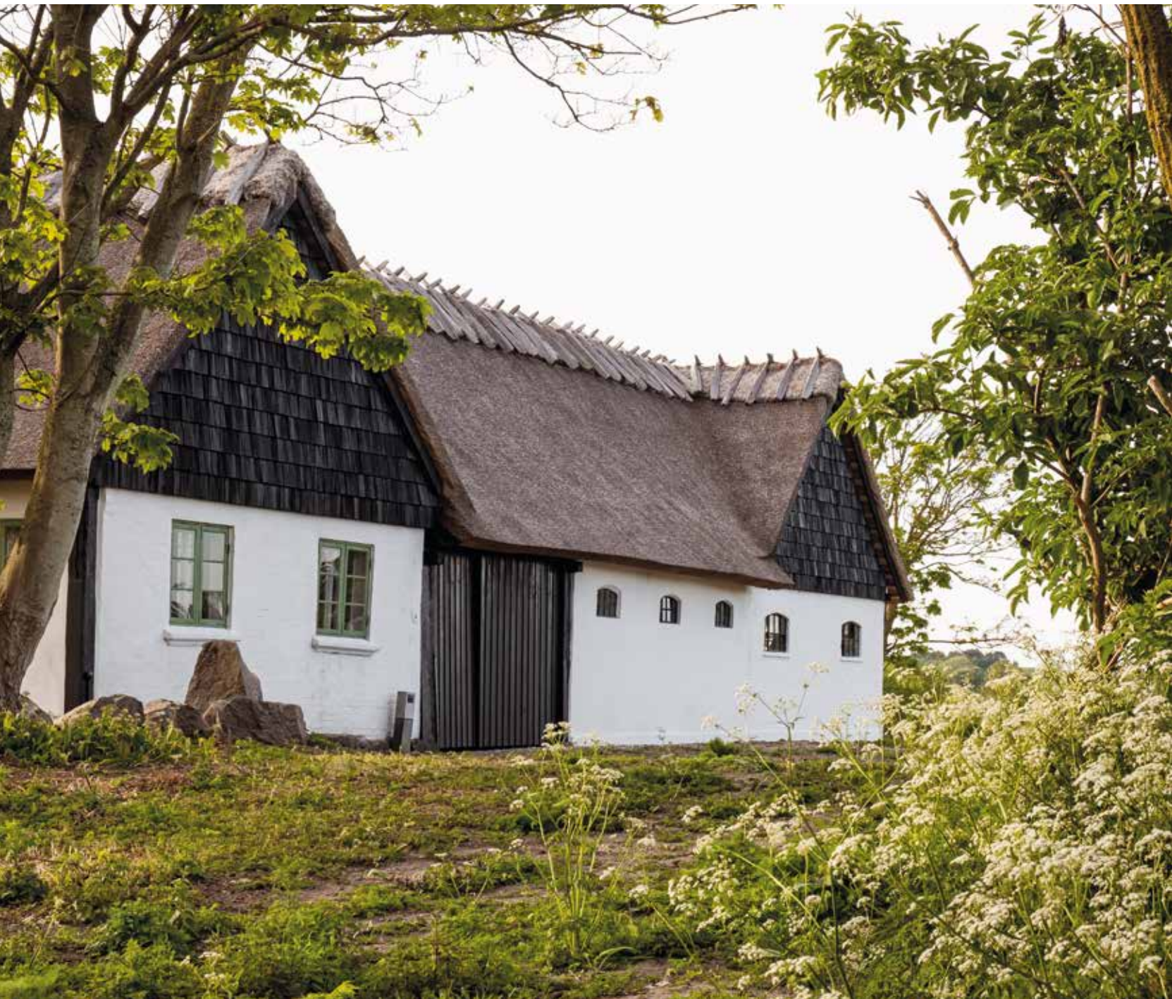
Staldlængen på Højgården har helgavl, som er beklædt med spån af fyrretræ og behandlet med træ tjære.
