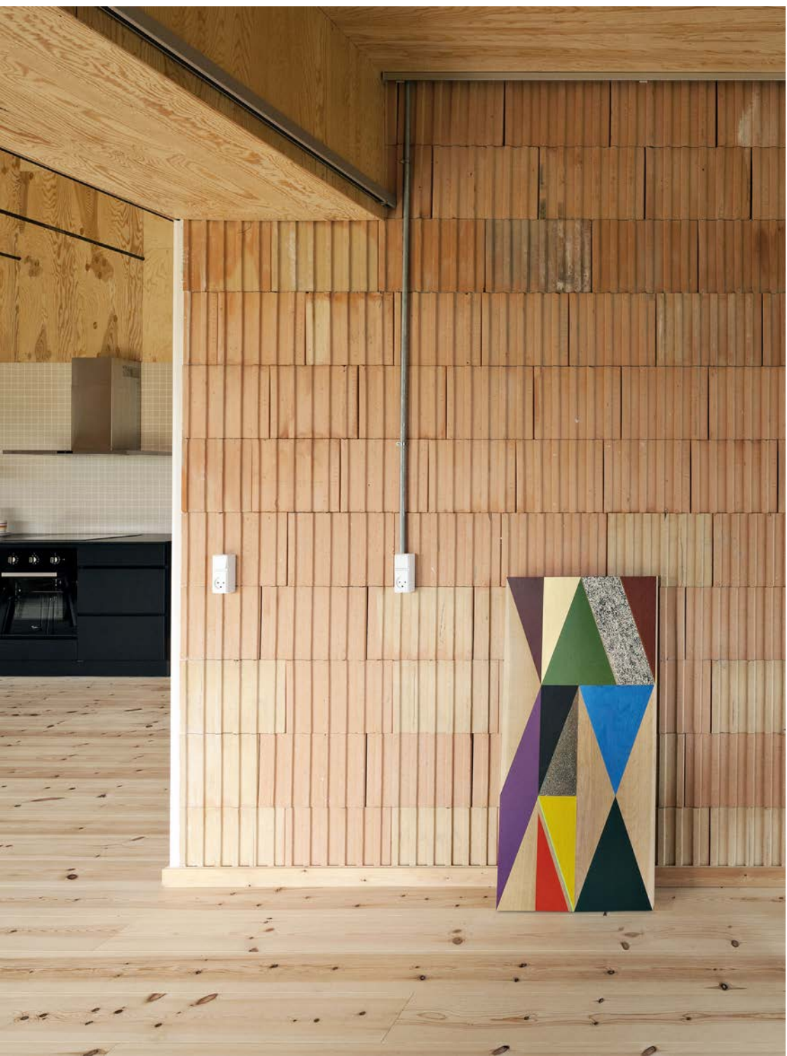
LEVETID | INDVENDIGE VÆGGE I BLANK BLOKMURVÆRK
