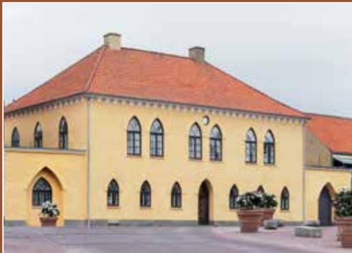
Råd-, ting- og arresthuset i Vordingborg Arkitekt: Peter Ernst Iver Kornerup Opført: 1843
