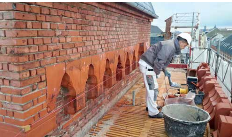
Savtaksfrise under tårnets tag under restaurering.
